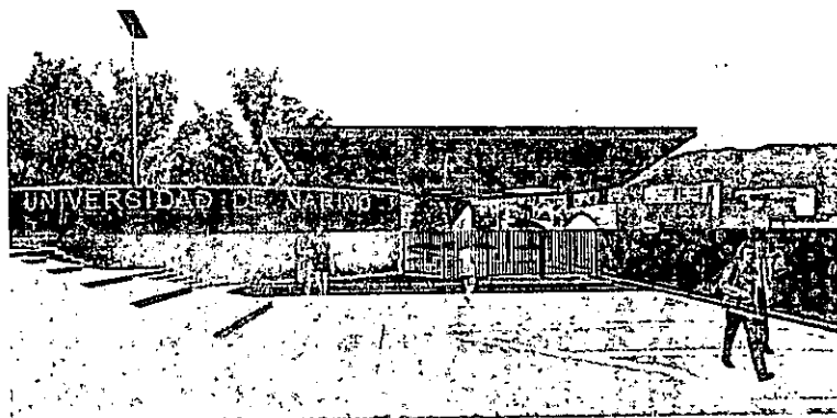
Figura 4. Plazoleta de acceso campus Torobajo
