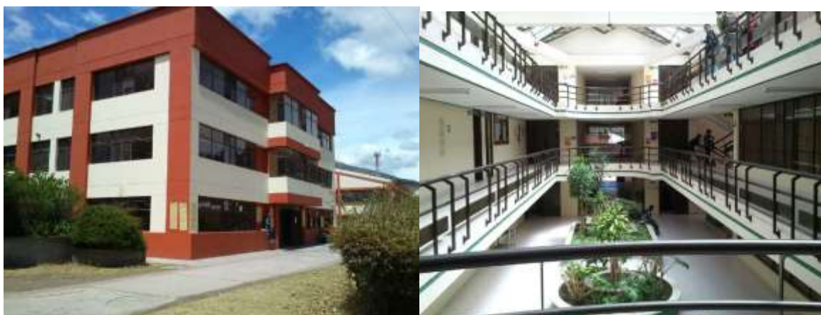
Imagen 1. Edificio de la facultad de ingeniería, destinado a la realización de tareas de docencia, oficinas administrativas, sala de docentes y de dirección del programa y facultad.
