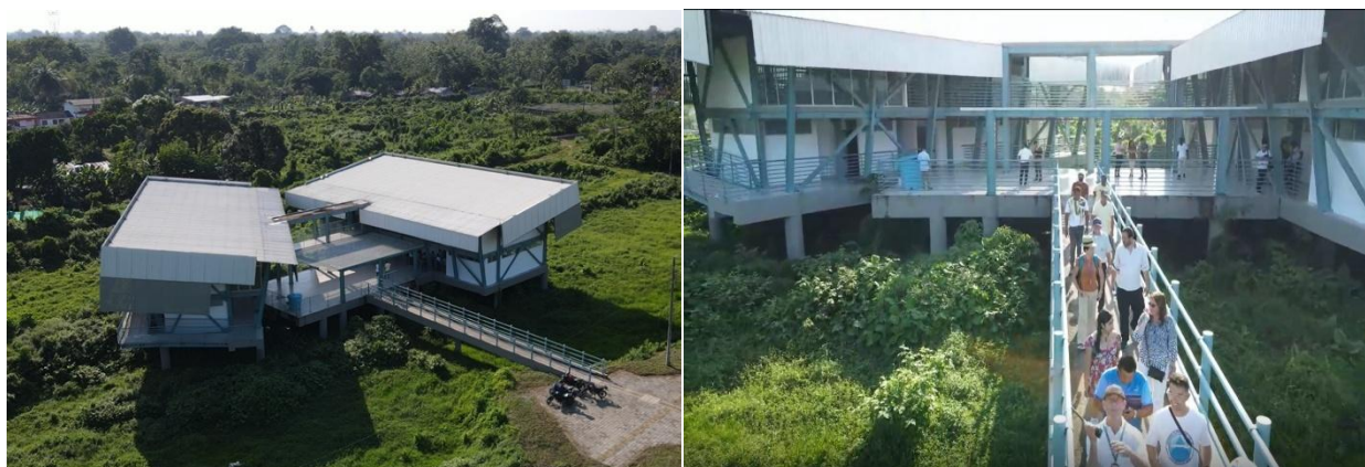
Bloque administrativo y de laboratorios de la Sede Mar Agrícola
