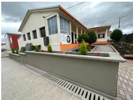
Infraestructura Casa Antigua
