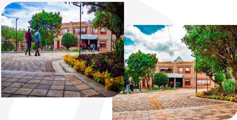
Obras de Urbanismo Fase II – Sede Ipiales de la Universidad de Nariño
