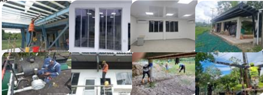
Adecuaciones y mantenimiento Sedes Ciudadela y Mar Agrícola de la Universidad de Nariño – Sede Tumaco
