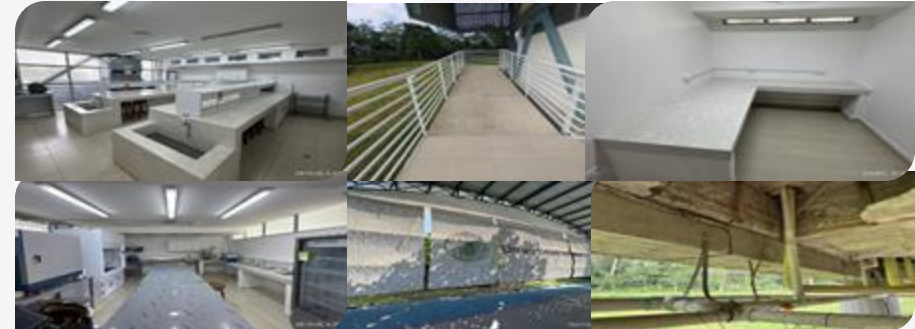
Obras de adecuación y mantenimiento Fase II en las Sedes Ciudadela y Mar Agrícola de la Universidad de Nariño – Sede Tumaco
